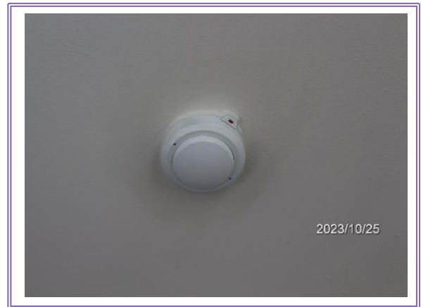
รูปที่ 2.8-2 เครื่องตรวจจับความร้อน
