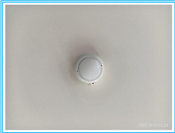
รูปที่ 3-39 อุปกรณ์ตรวจจับความร้อน
