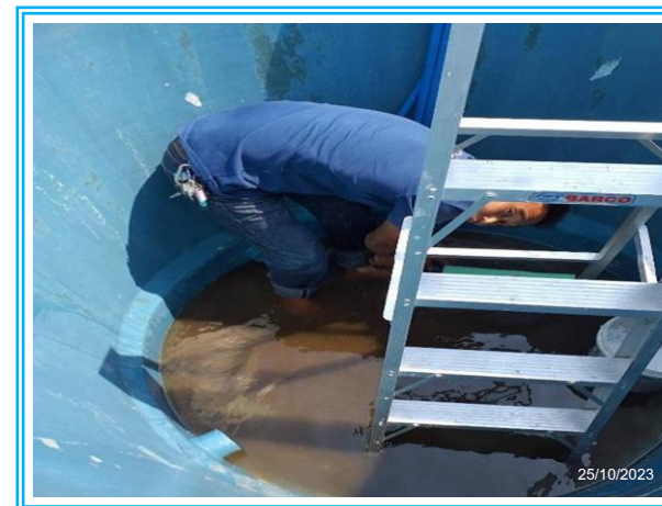
รูปที่ 3-23 การล้างถังสำรองน้ำของโครงการ
