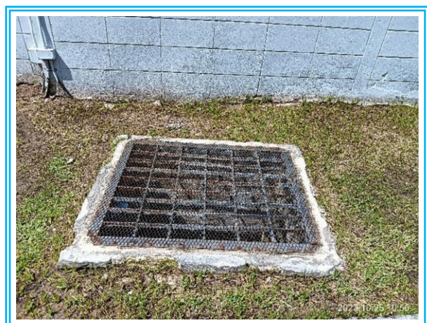
รูปที่ 3-24 ตะแกรงครอบท่อระบายน้ำ
