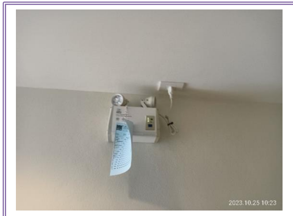
รูปที่ 2.8-5 ไฟส่องสว่างฉุกเฉิน
